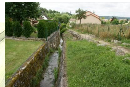
Ruisseau traversant le lotissement des Evelottes 3
