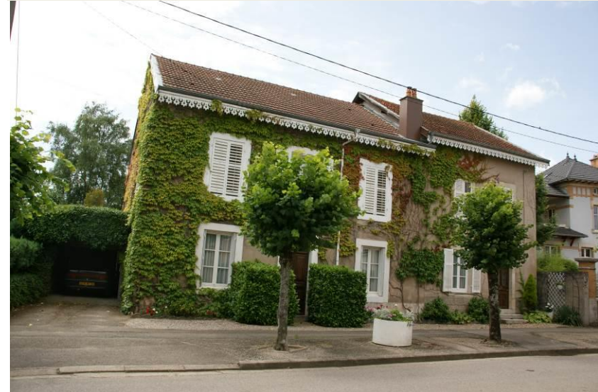
T- 56-58 Avenue de la gare Maison 1900
