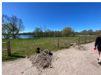
Clôture des Étangs Remplacement en cours
